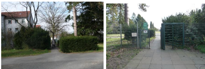
Abbildung 35: Eingangsbereich Richthofenstraße, links von innen, rechts von außen 2021 (Fotos: Bertram)
